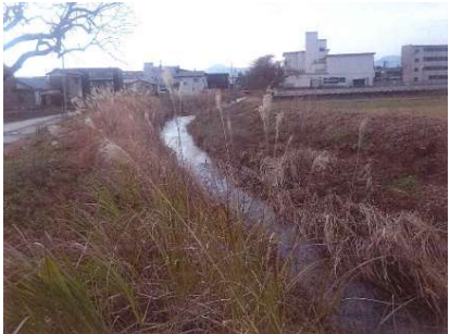
小松川浚渫前
