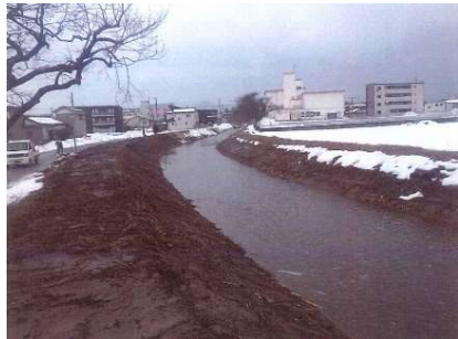
小松川浚渫後
