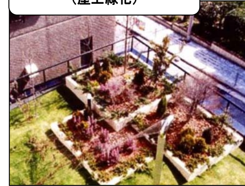
東邦レオ本社ビル・大阪市 (屋上緑化)
