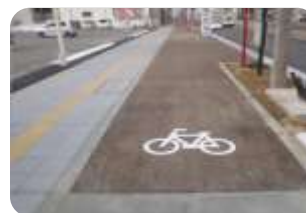
歩道内の明示・分離
