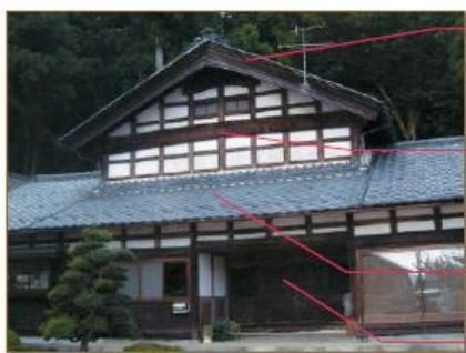
〈屋根〉切妻屋根・瓦葺き（嶺北は越前瓦葺き）
