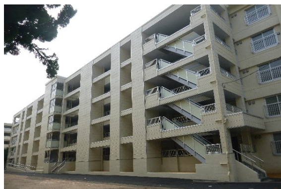
県営住宅の全面的な改修事例
