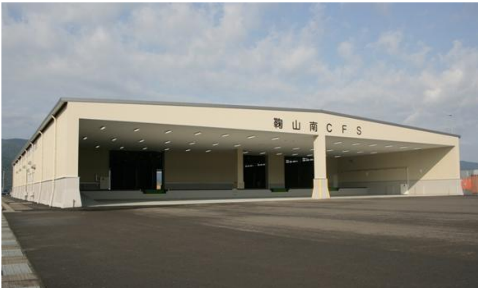
敦賀港CFS上屋建設工事 敦賀市 平成25年10月竣工
