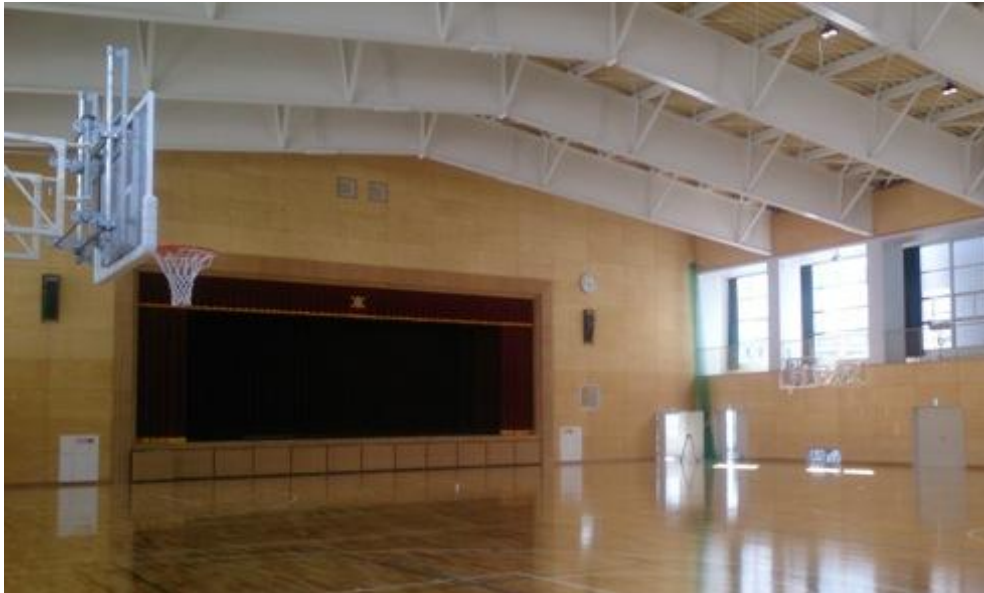
坂井総合産業高校（仮称）第1体育館建設工事 坂井市 平成26年3月竣工
