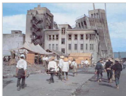
福井大震災の被害状況
