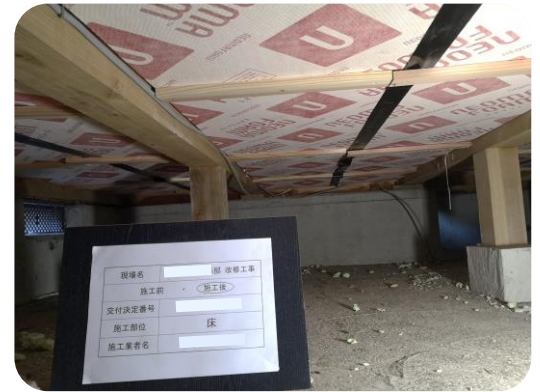
既存の断熱材に追加で断熱材を施工
