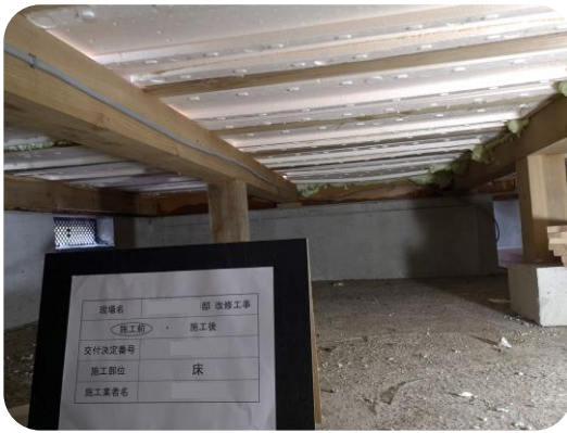
改修前の床下
