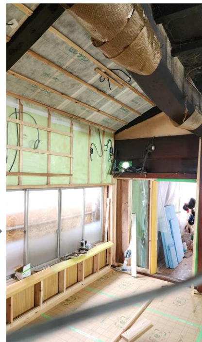
断熱、気密 → 施工中の様子
