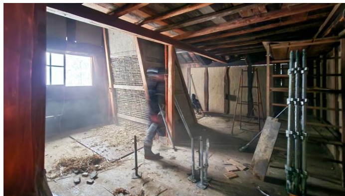
← 改修前（内装材撤去後）の様子
