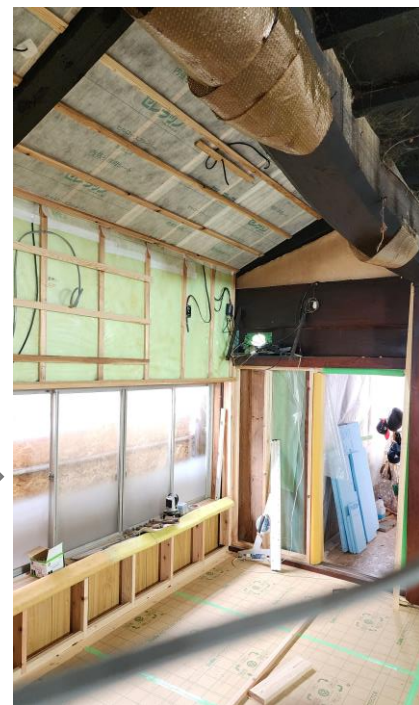
断熱、気密 → 施工中の様子
