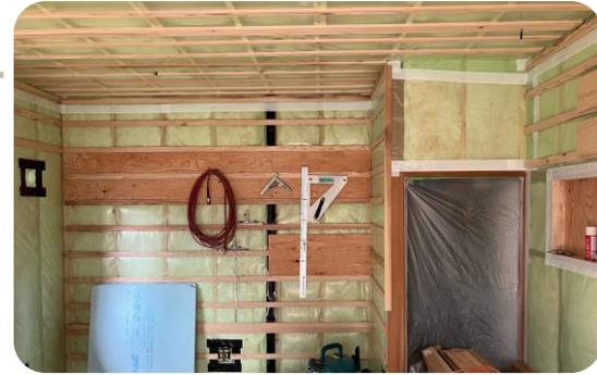
断熱・気密施工後の壁・天井
