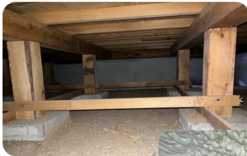
改修前の床下
