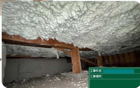
断熱施工(ウレタン吹付)後
