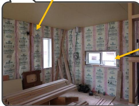
窓：アルミ樹脂複合サッシ +ペアガラスに改修 (改修しない部屋は内窓設置)
