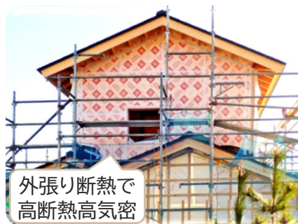
屋根断熱& 屋根軽量化
