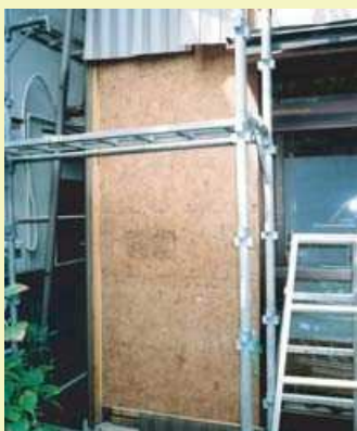
ケナフボ - ド張り
