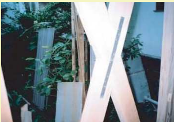
筋かい新設 補強金物
