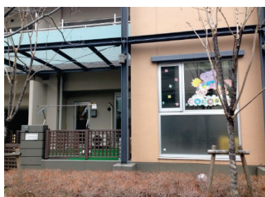
写真Ⅱ.104 地域の住宅を改修して設置された 小規模保育室
