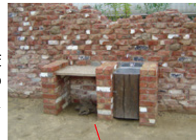
写真Ⅱ.85 居住者の交流のための バーベキュー 設備
