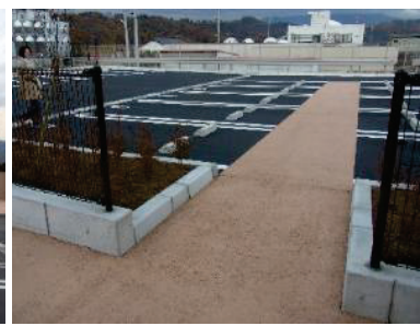
写真Ⅱ.95 住棟まわりの歩行者専用スペースから駐車場への歩行者道は同じ色彩の仕上げ材を用いている
