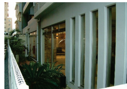
写真Ⅱ.59 注1) 外部からの見通しが確保された エントランスホール
