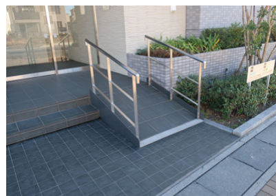
写真Ⅱ.56（右上）、写真Ⅱ.57（右下） ベビーカーでの移動にも配慮された住棟 エントランスに設置されたスロープ
