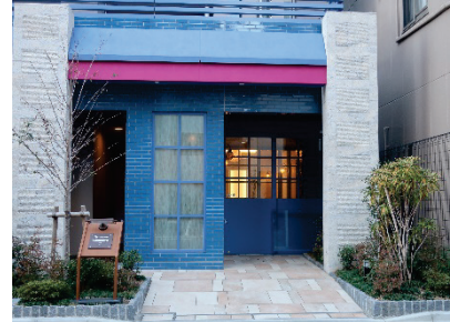
写真Ⅱ.81 正面右側がエントランスドア・左側は 宅配ボックスの前入口に至る
