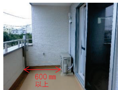
写真Ⅱ.54 手すりからの離隔距離を確保した 室外機置場
