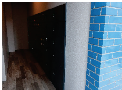
写真Ⅱ.82 写真Ⅱ.81の宅配ボックス及びメールボッ クスの前入口スペース（住棟外部）
