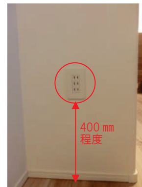
写真Ⅱ.8 通常よりも高い位置に設置されたコンセント（ハイハイする乳児の手に届きにくく、大人にとっては、屈まずに使用できる）
