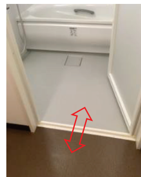
写真Ⅱ.25 浴室出入り口の段差はできる限り小さくする
