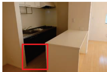
写真Ⅱ.35 チャイルドフェンスの設置可能なキッチン 入り口（両側は木製の壁、カウンター）
