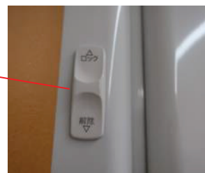
チャイルドロック(子どもの手が届きにくい位置に設けられた外側から施錠・解錠できる錠)付きの浴室ドア
