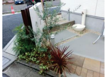
写真Ⅱ.55 屋外に設置された手洗い水栓
