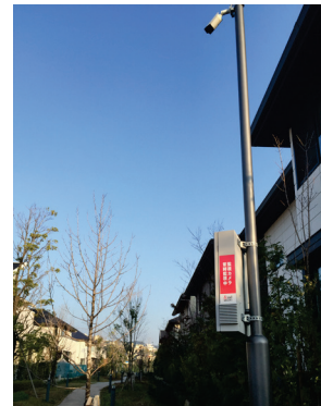
写真Ⅱ.103 遊歩道沿いの街灯に設置された 防犯カメラ
