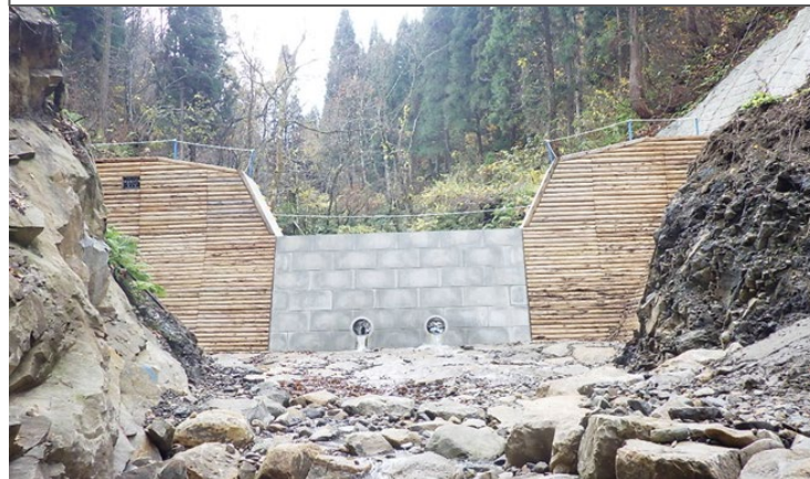
【治山ダム工（大野市角野）】
