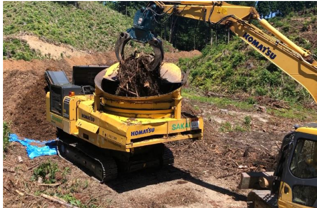
木質バイオマス燃料調達実証事業 (坂井市)
