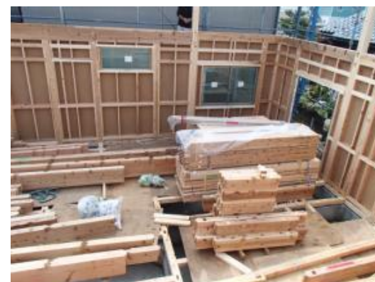
パネル工法建築現場
