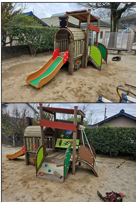
遊具の設置状況
