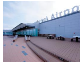
新素材を活用したデッキ (ウッドプラスチック)
