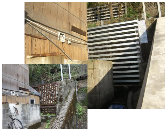
治山施設(土留工)の補修 (越前町高佐)
