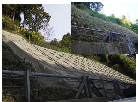
治山施設(法枠工)の補修 (おおい町大島)
