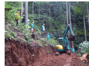
作業道作設研修
