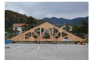
トラス梁工法
