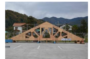
トラス梁工法
