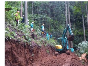
作業道作設研修
