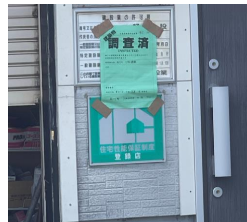
R8熊本地震における応急危険度判定（氷川町の状況；リエゾン撮影）
