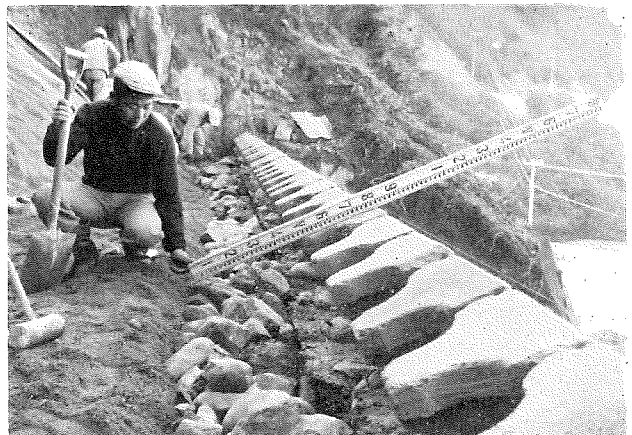
災害復旧工事
