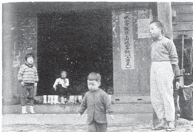
西谷村上笹又の被災者収容所
