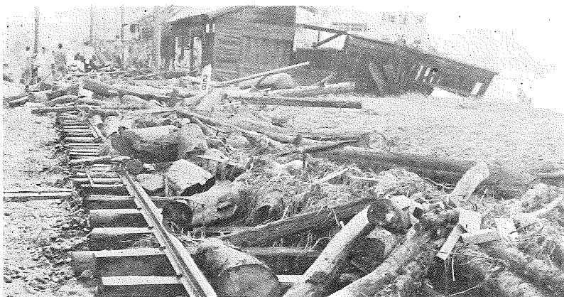
奥越集中豪雨による京福電鉄勝山駅(福井県勝山市)
