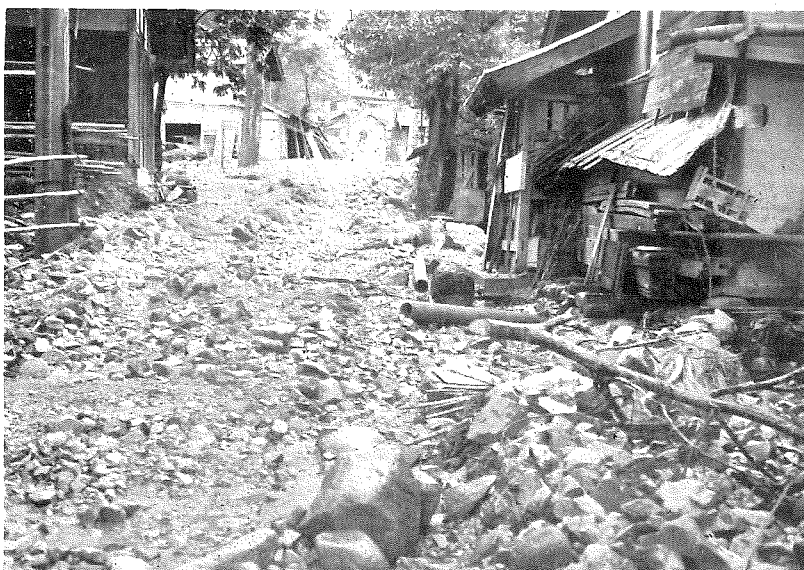
配水管流失状況
