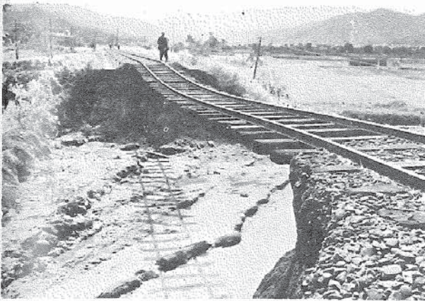
小浜線美浜—三方間の築堤欠壊 軌道延長500米
