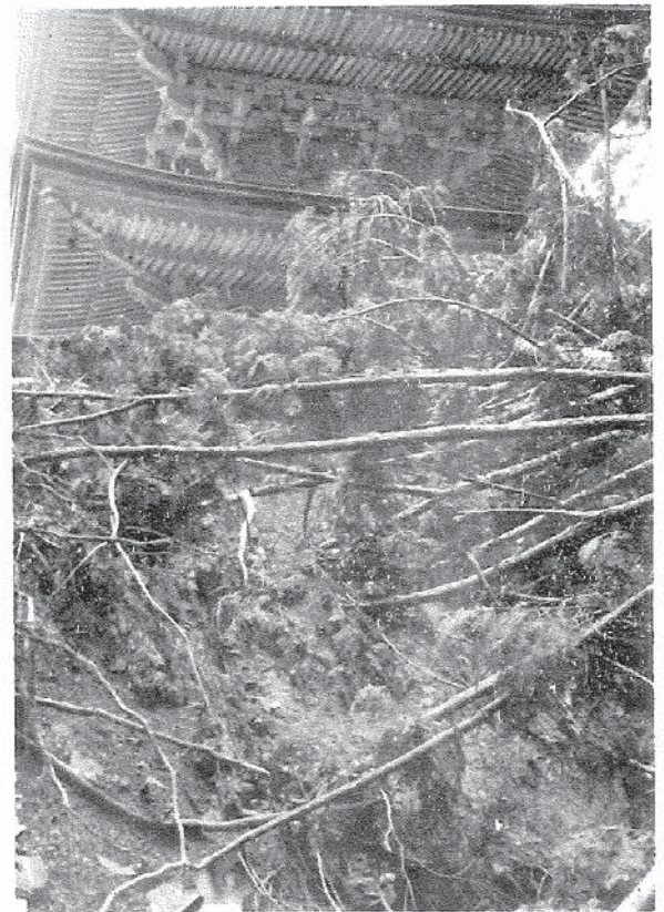
国宝、明通寺三重塔、被害状況
