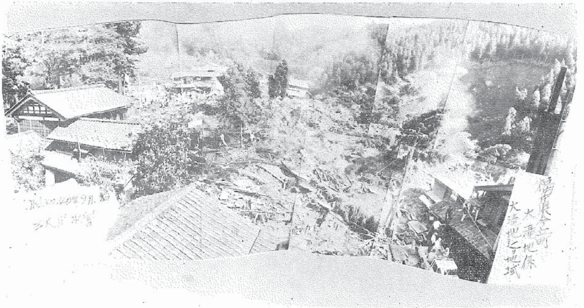
一瞬11棟の家屋倒壊、14名が生埋め（10名は死亡した）になった今立町大滝の被災状況
