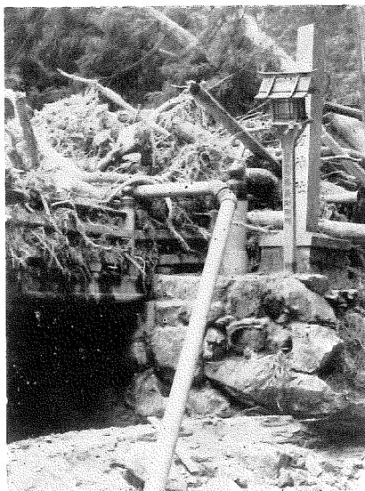
濾過地の土砂埋没及び基礎保護石積欠潰状況
