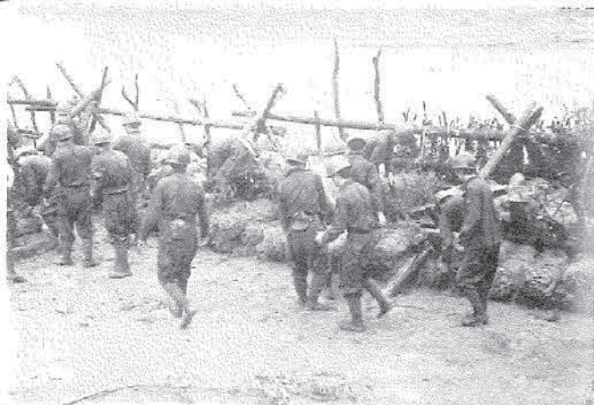
護岸工事に活躍する自衛隊員 (大野市佐開橋附近)
