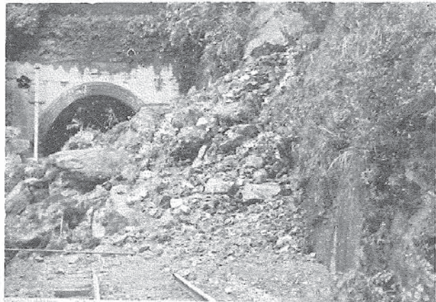
小浜線八幡山トンネル出口
