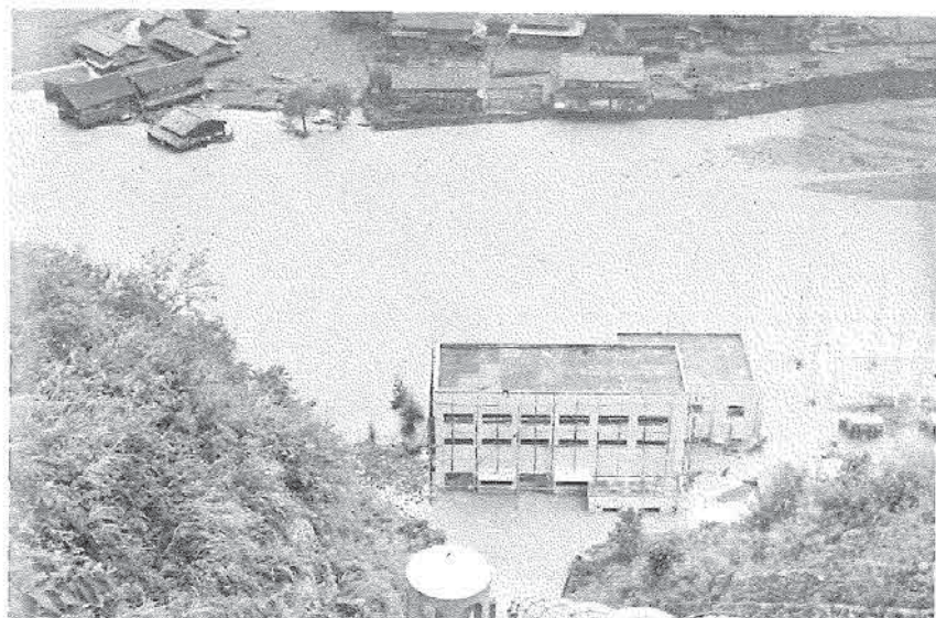
笹生川の流心に孤立した 中島発電所 (鉄管路より望む)
