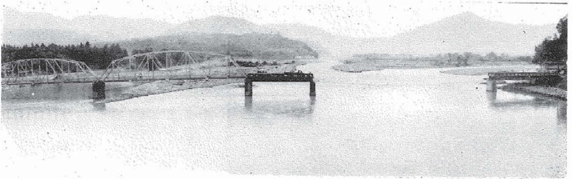
一般国道 157 号線 勝山市 下荒井橋
