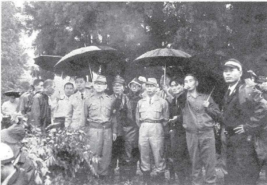
被災地を視察する建設大臣の一行（大野市佐関橋附近）
