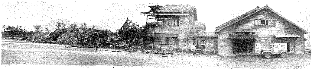
23号台風で倒壊した大野市富田小学校の校舎全景
