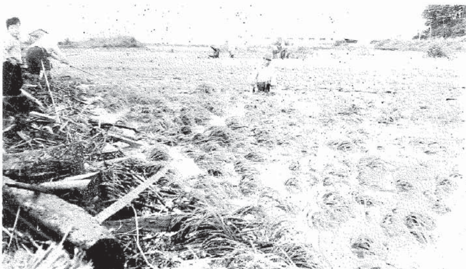
金津町矢地冠水現場
