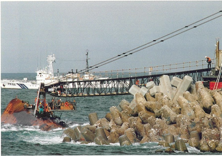
大型クレーンによる残油抜き取り（H9.2.14三国町）
