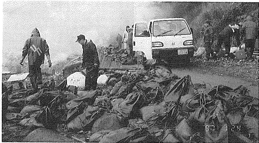
高浜② 回収に利用した土嚢袋
