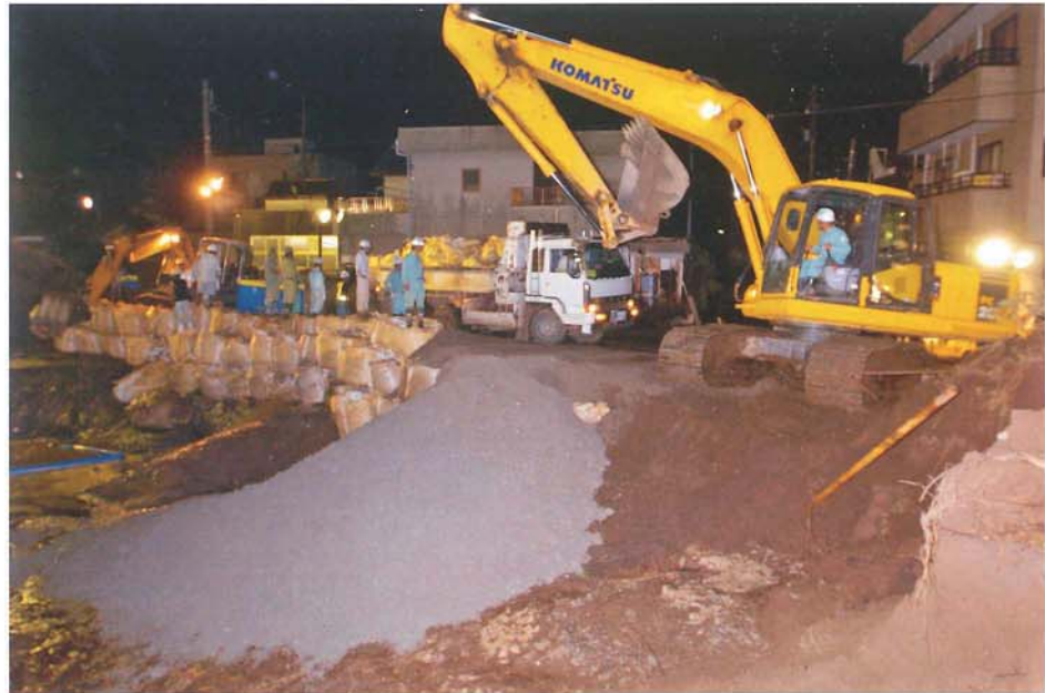
写真-5.6 足羽川の決壊箇所の修復 （福井市春日1丁目） （福井新聞社提供）
