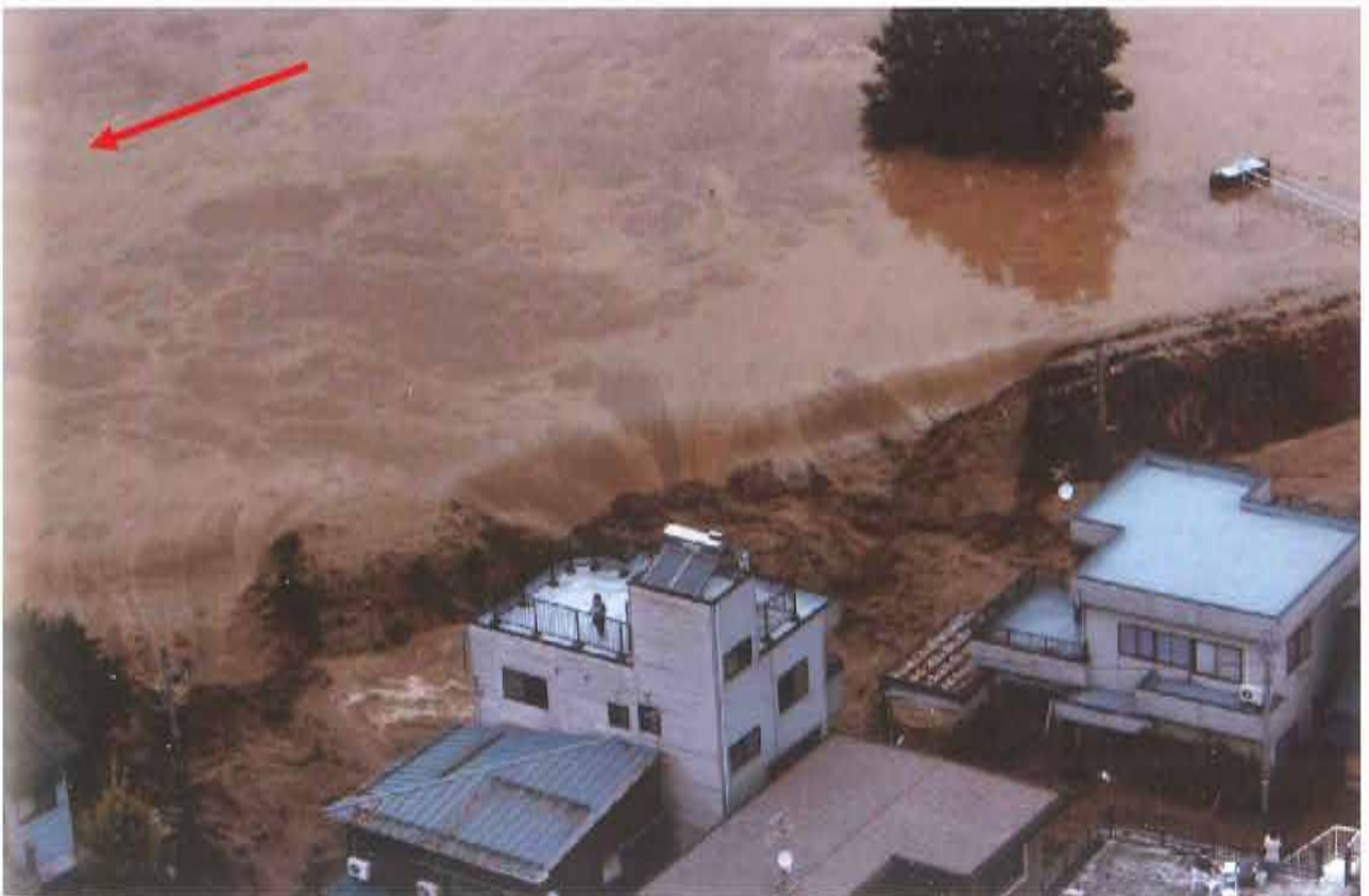
写真-2.8 足羽川の決壊状況（福井市春日1丁目）（日刊県民福井提供）
