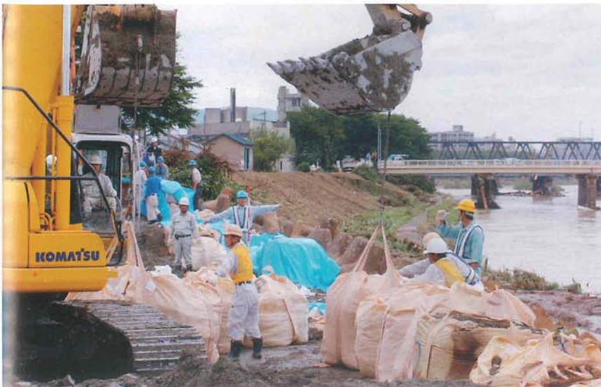
写真-5.6 足羽川の決壊箇所の修復 （福井市春日1丁目） （福井新聞社提供）
