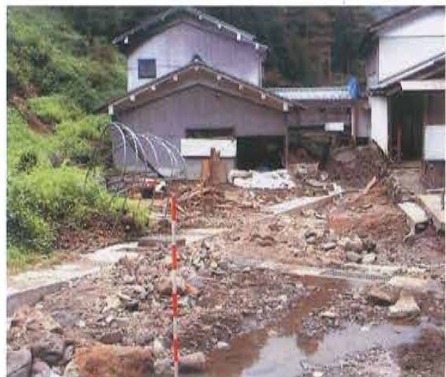
写真-2.6 がけ崩れ (鯖江市上河内)
