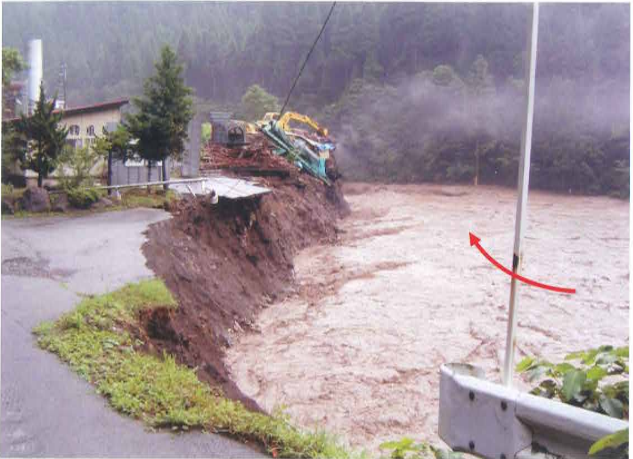
写真-2.9 足羽川の河岸浸食状況（池田町持越）
