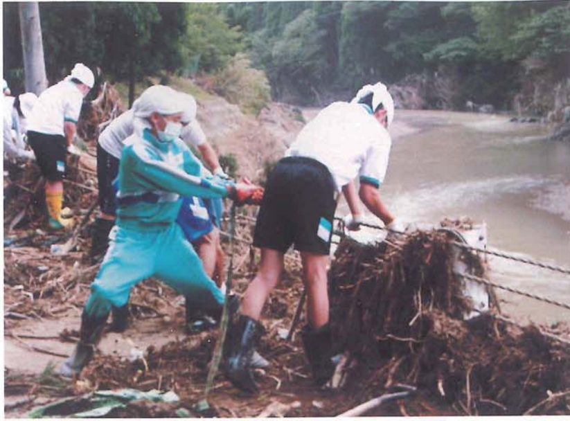
写真-5.12 池田中学校生によるボランティア活動（池田町白栗 発電所付近）
