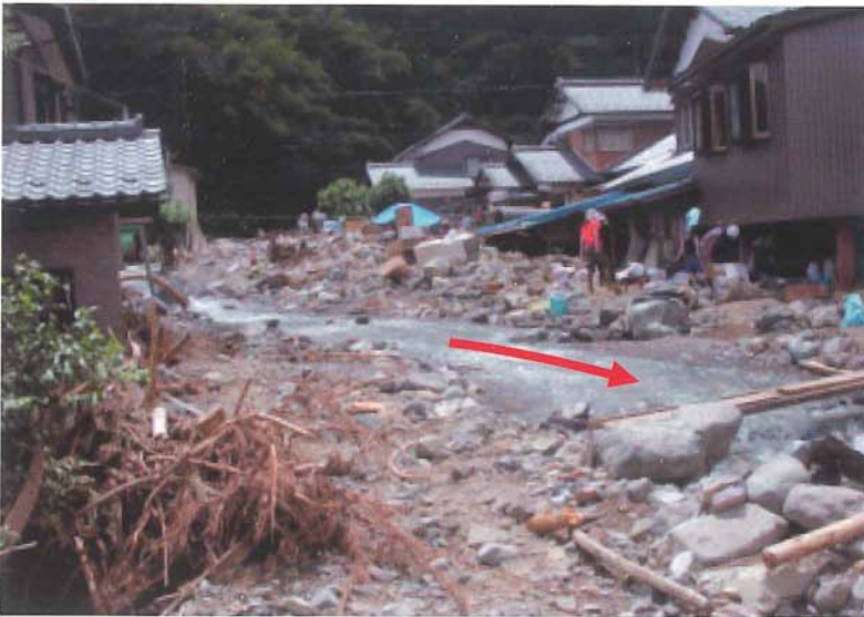
写真-4.1 土石等堆積状況（美山町蔵作）
