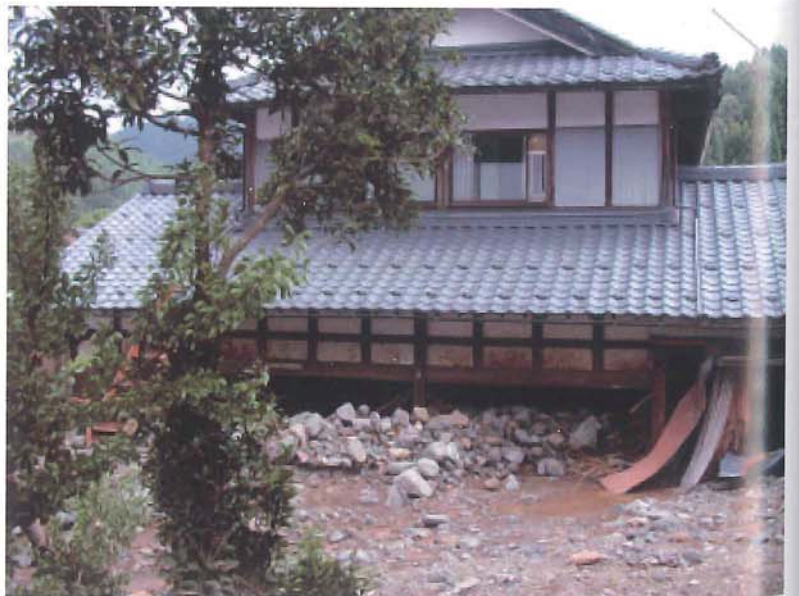
写真-4.2 土石等流入状況（美山町蔵作）
