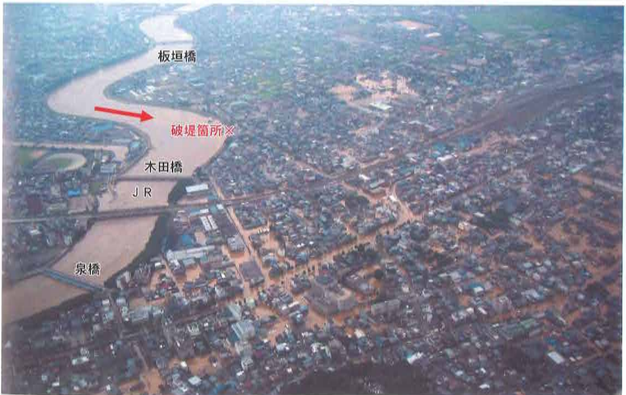
写真-1.1 上空から見た福井豪雨（足羽川 破堤箇所周辺の浸水状況）
