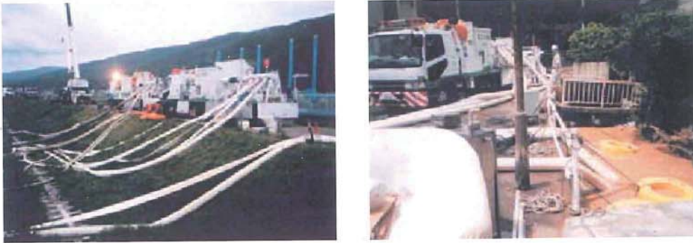
写真-5.1 排水ポンプ車による排水活動
