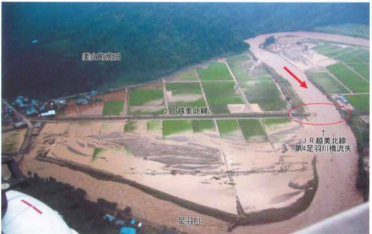
写真-1.2 上空から見た福井豪雨（足羽川 美山町高田地区）
