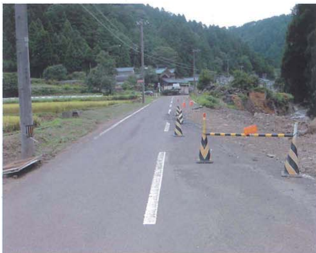
写真-6.24 災害復旧状況
