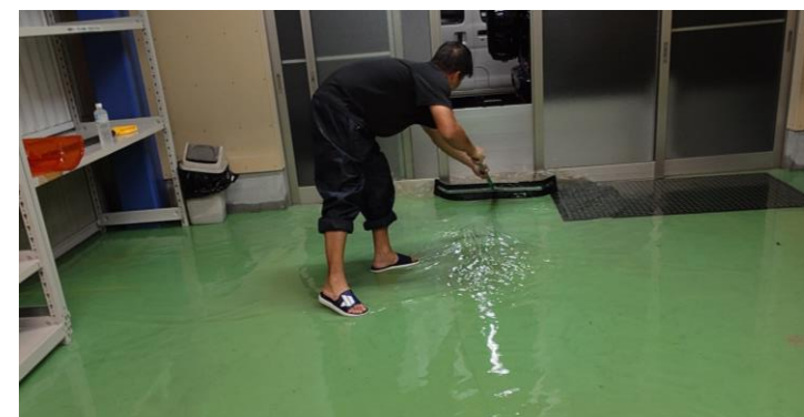
工場内への浸水
