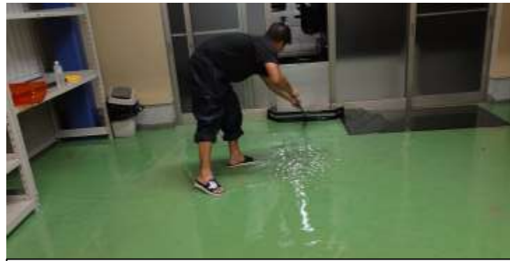
工場内への浸水
