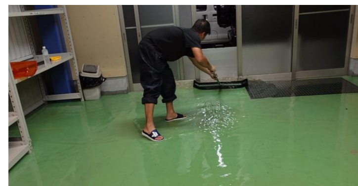
工場内への浸水
