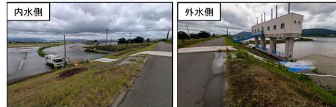
ハケ川樋門 排水状況
