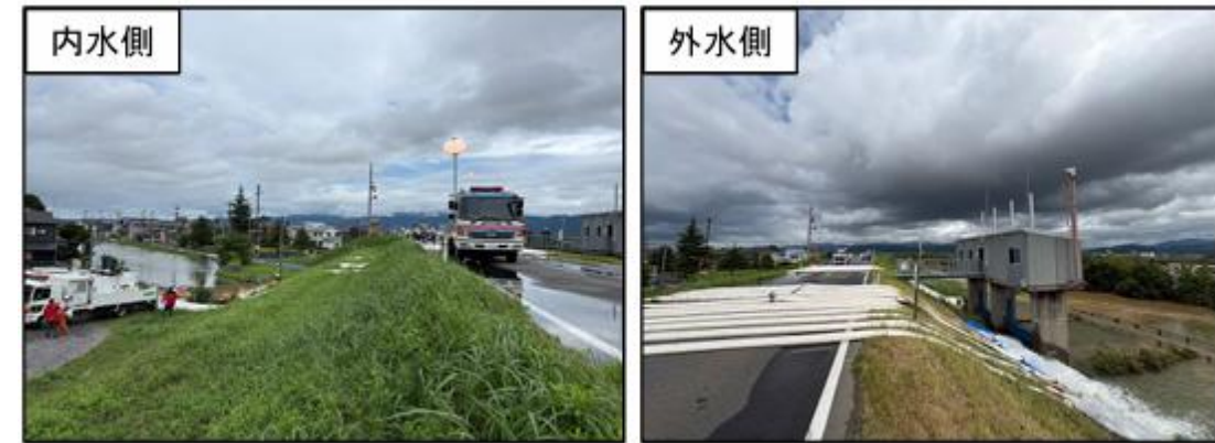
芳野川樋門 排水状況
