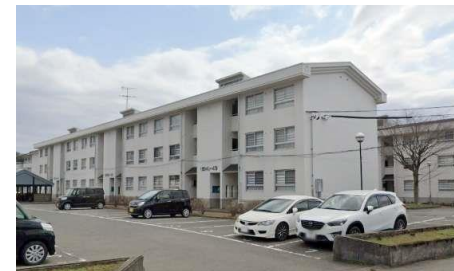
県営住宅上野団地
