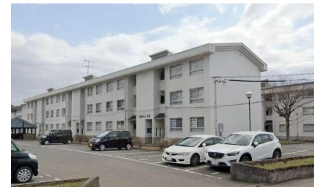
県営住宅上野団地
