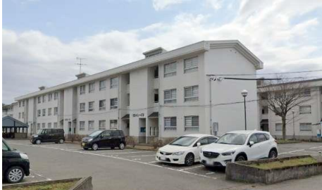
県営住宅上野団地
