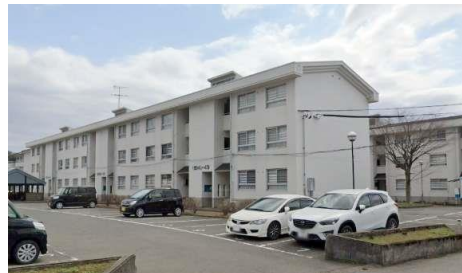
県営住宅上野団地
