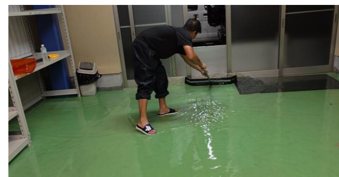
工場内への浸水
