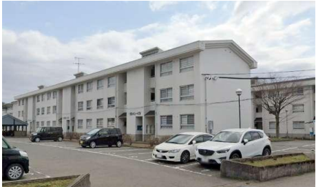
県営住宅上野団地
