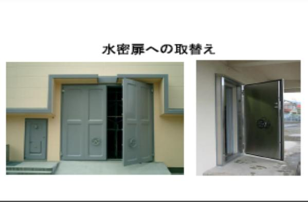
タービン動補助給水ポンプ、DG、受電盤等のプラント安全上重要な設備の津波による冠水を防止するため、水密扉への取替えを行なう。
