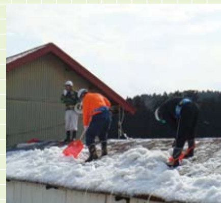
地域住民による屋根の雪下ろし
