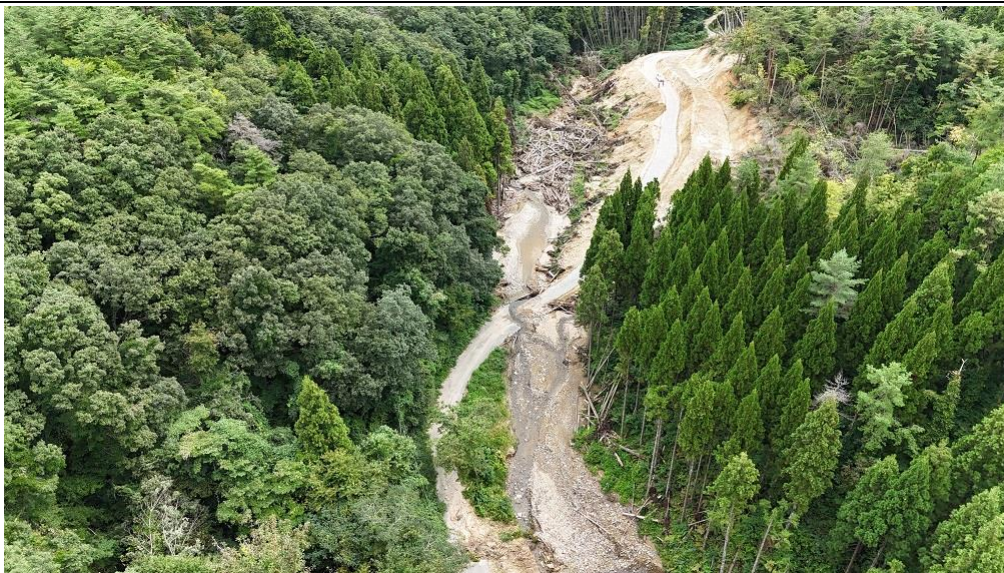
9/30 ドローンからの撮影（石坂橋）
