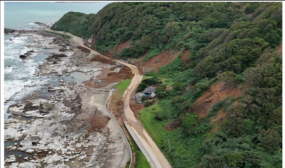
10/5 ドローン調査_馬縞町（土砂崩れ状況）
