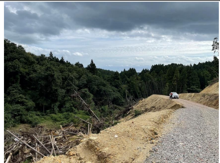
9/30 ドローンにより被害状況を確認
