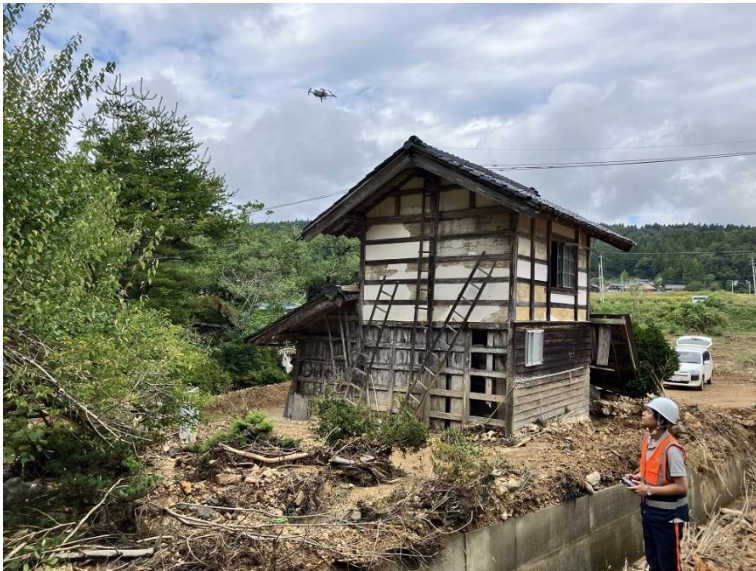
10/16 ドローン調査（若山地区）
