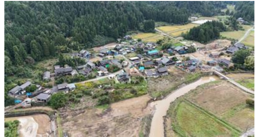
10/16 ドローン調査（若山地区）
