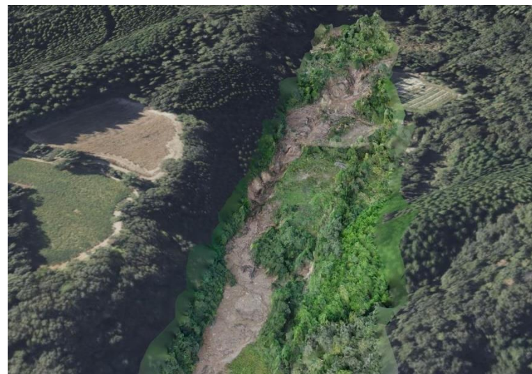
10/12 ドローン調査整理(若山地区)
