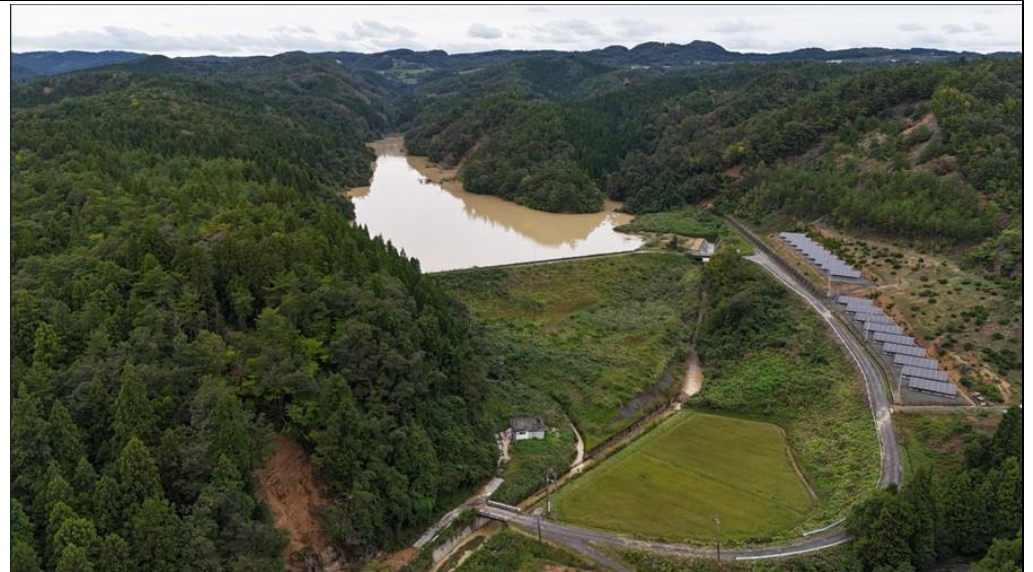
10/8 ドローン調査 (岩坂ダム)
