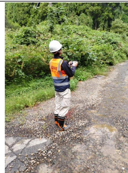
10/9 折戸工区の一部をドローン撮影
