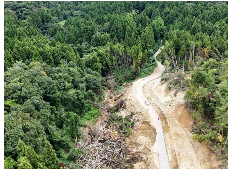
9/30 ドローンにより空から被害状況を確認
