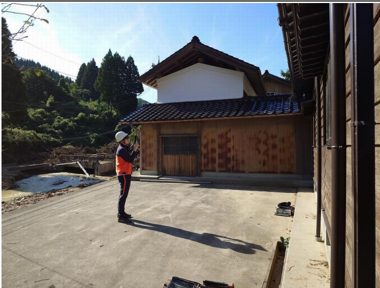
10/14 被害家屋調査（若山地区）
