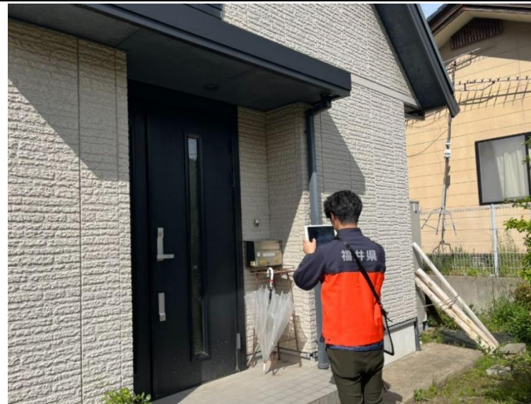
10/10 被害家屋調査
