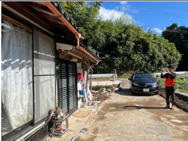
10/9 被害家屋調査
