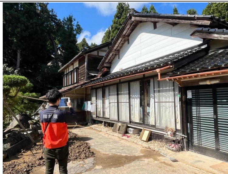
10/9 被害家屋調査
