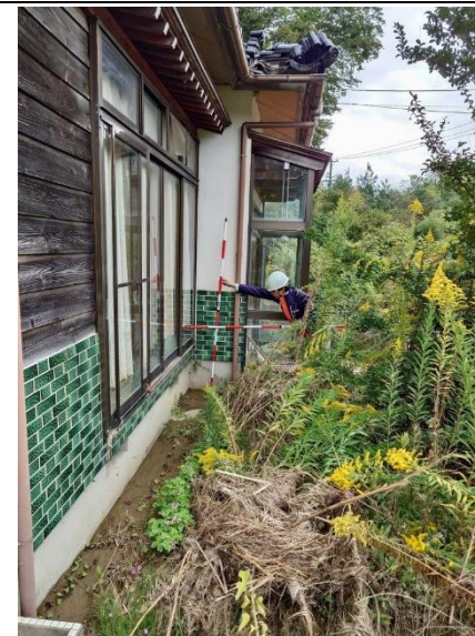
10/15 被害家屋調査（若山地区）
