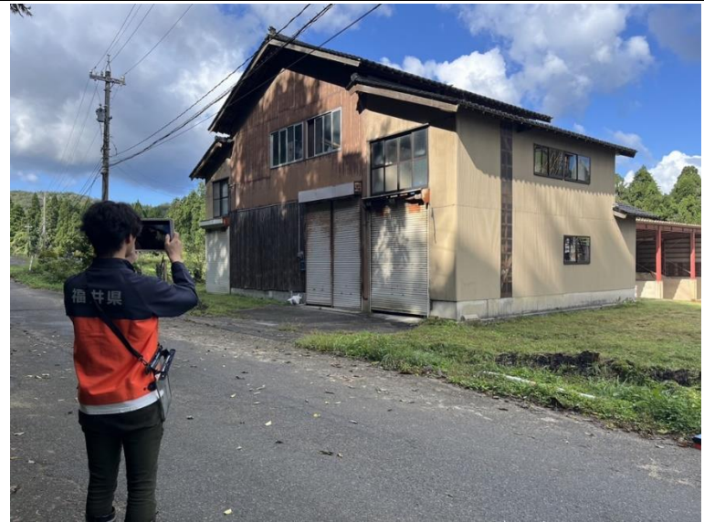
10/11 被害家屋調査
