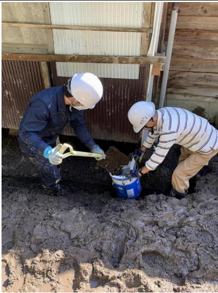
10/9 災害ボランティア（正院地区での泥出し）
