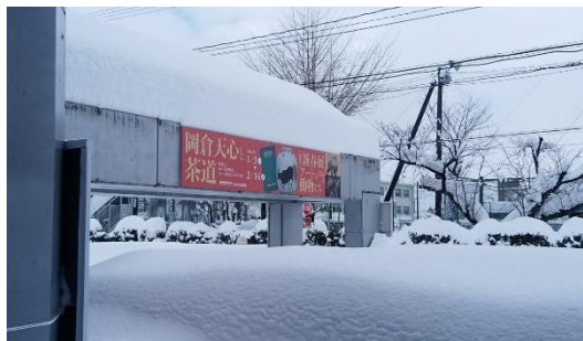
正面玄関の様子
