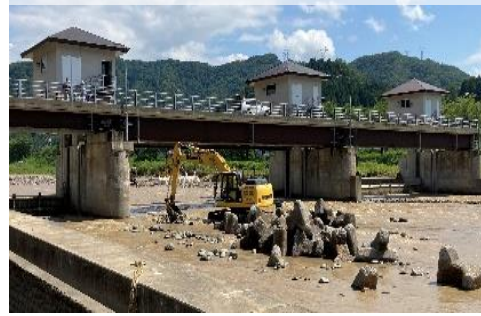
八乙女頭首工への土砂流入(日野川)
