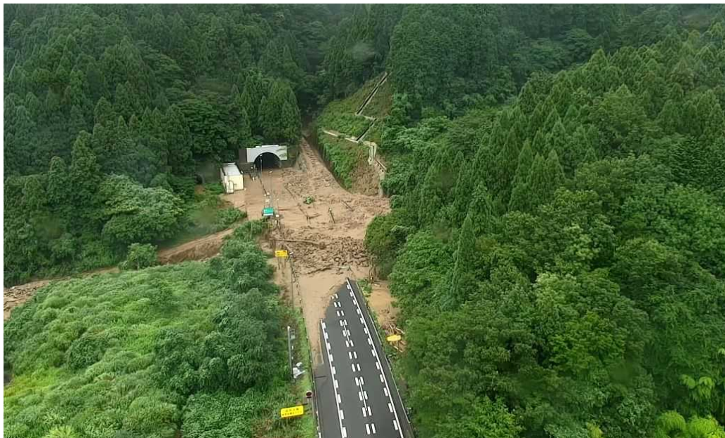
⑥下り58. 35KP 敦賀 TN 坑口付近
