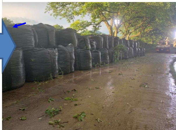
8/4 18:00川裏側土嚢設置完了
