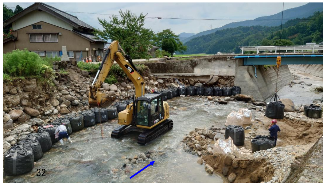
8/9 13:50大型土嚢設置作業状況
